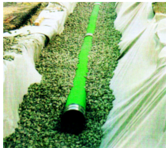
Rigolenversickerung mit Kiesummantelung
