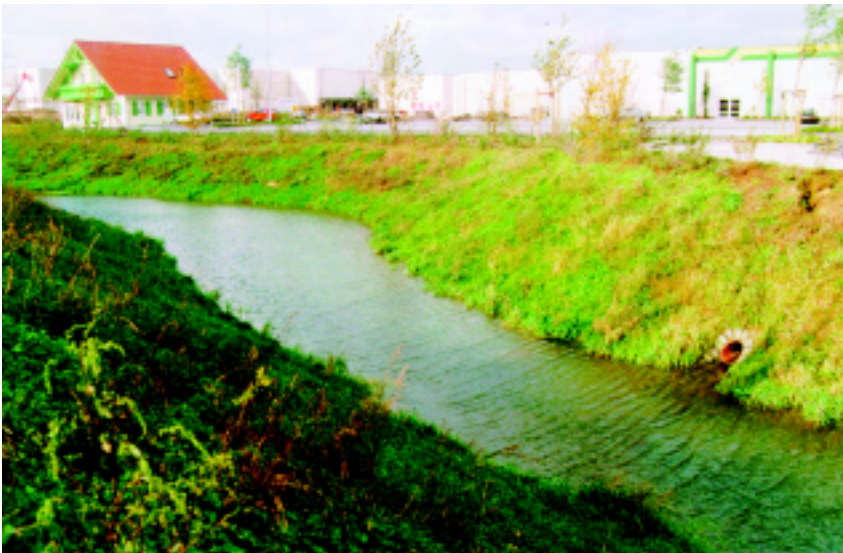
Sickerbecken eines Baumarktes in Troisdorf
