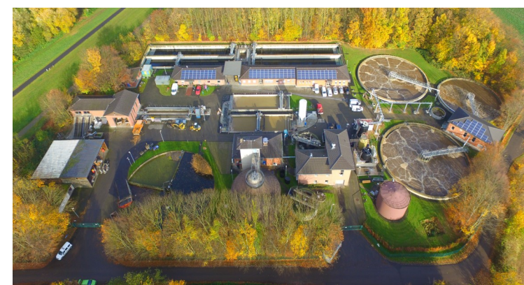
Dein Arbeitsplatz - Die Kläranlage Niederkassel
