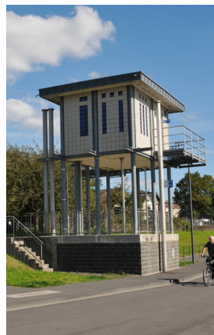
Pumpwerk Rheinallee - eines von über 30 Sonderbauwerken
